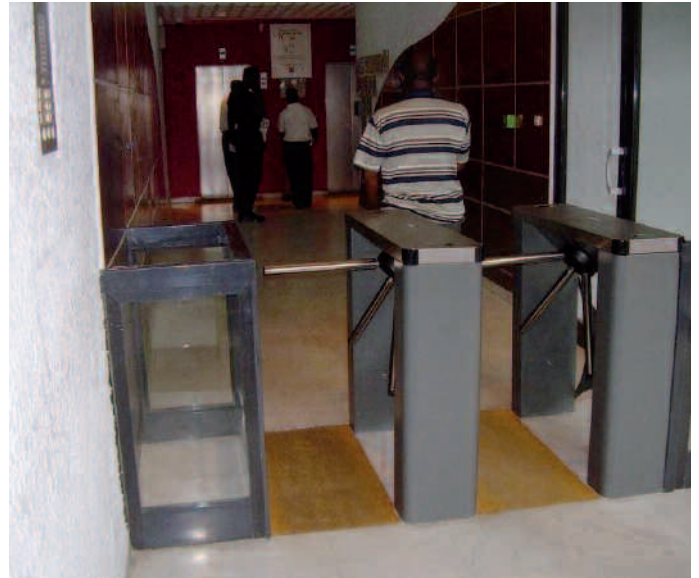
Vue du contrôle d'accès par tourniquet tripode
